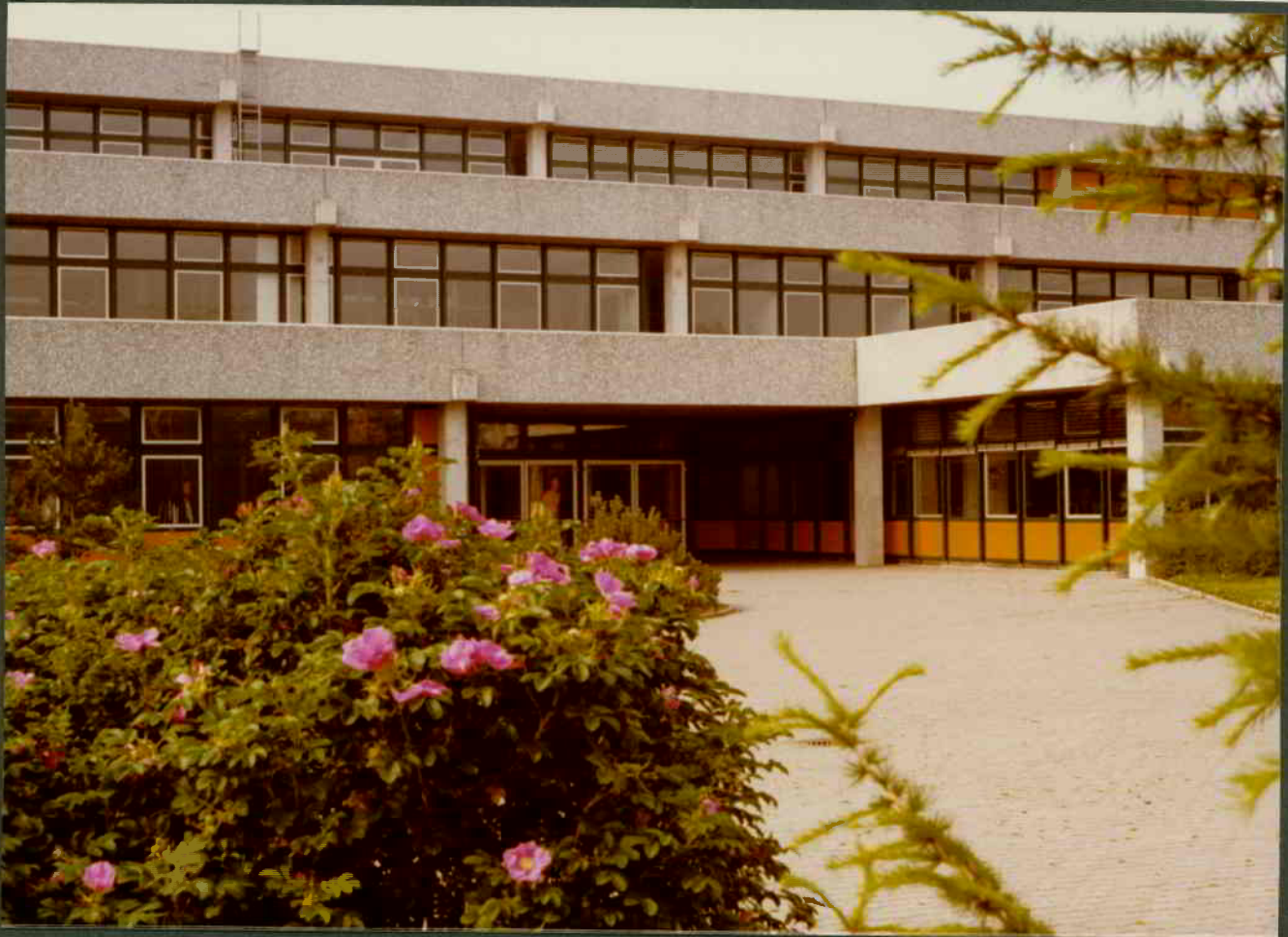
Fassaden Von-Galen- Schule Eichenzell
