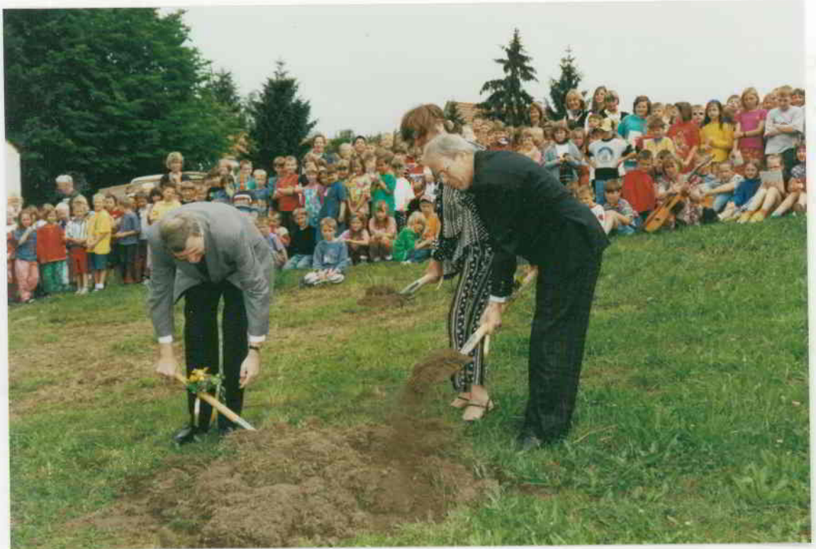
1. Spatenstich Erweiterung Friedhofsgelände Prigovci, am 08.08.1989
